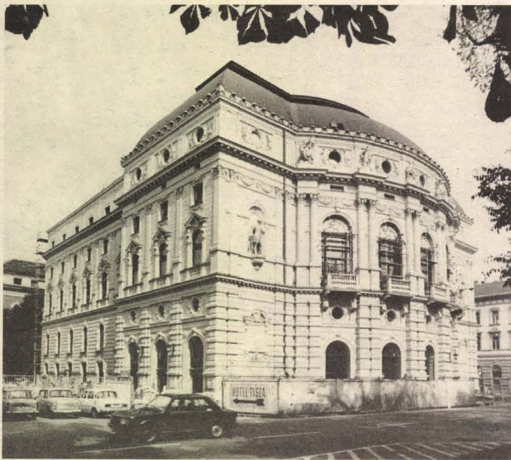
Befejezés előtt a szegedi Nemzeti Színház felújítása
